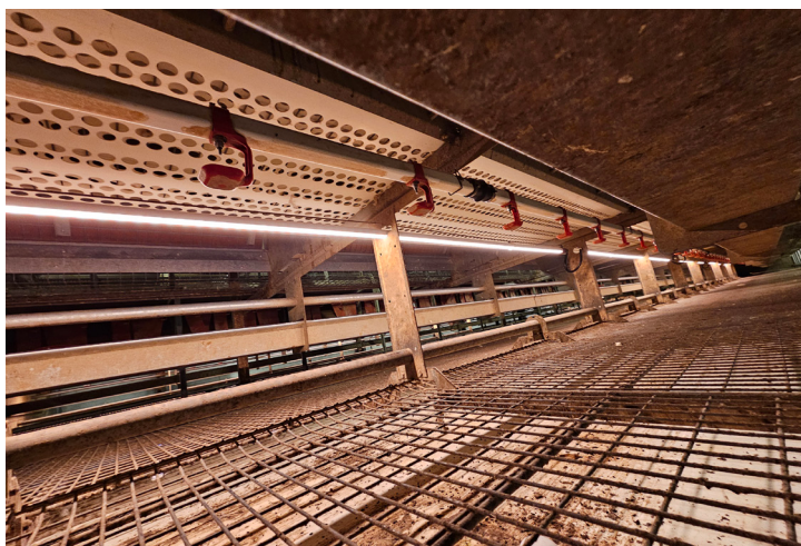
AVIARY-LIGHT unter dem Etagensystem montiert.
