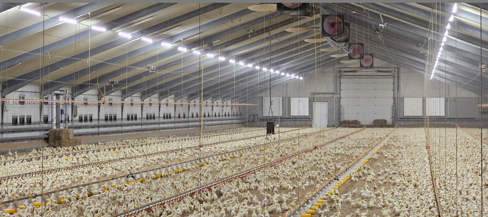
2 Leuchtenreihen bei Stallbreiten bis 20 m
