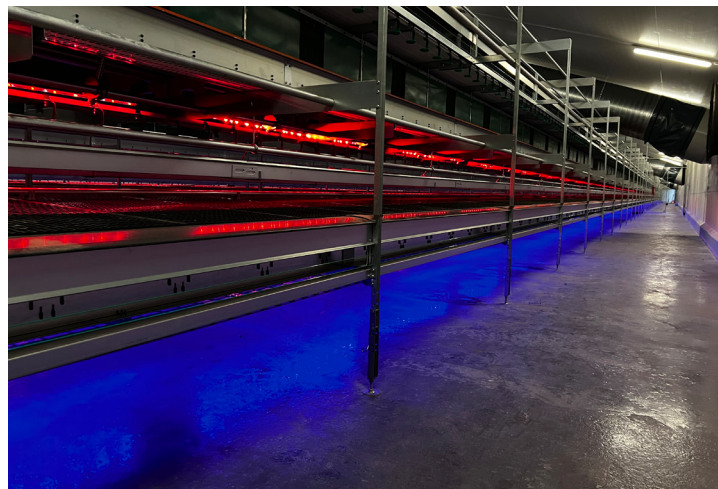
MIX TO BLUE findes med 180° spredning - én række dækker op til 250 cm.
