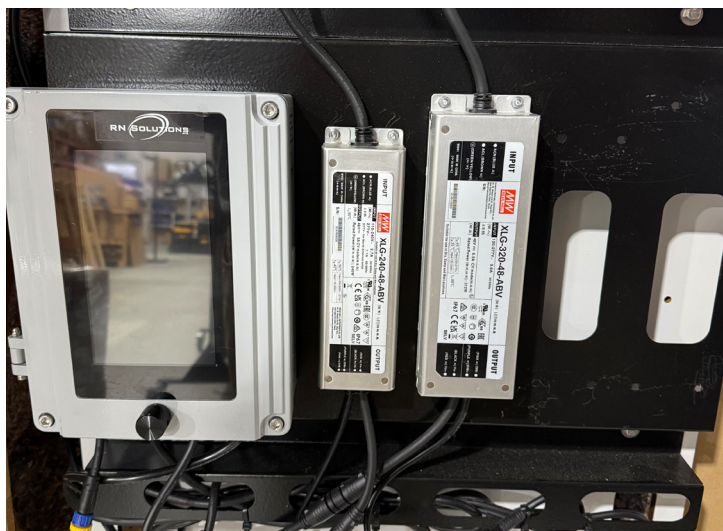
MeanWell-drivere leveres komplet som 100% Plug 'N Play - kræver kun 1 \times 13\text{A CCE} stik pr. driversæt.
