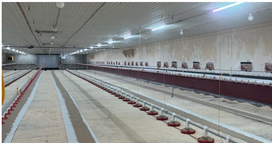
BROILIE-armatur med integrerede linser til effektiv lysfordeling - 100% 4000K hvidt lys.
