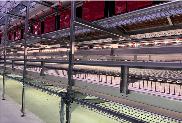
AVIARY-LIGHT instalada en el sistema de varios pisos.
