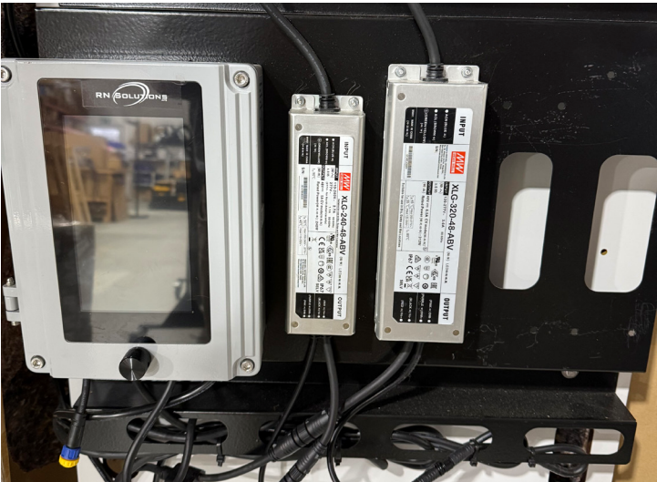
Zasilacze MeanWell dostarczane są jako kompletne 100% Plug 'N Play – wymagają tylko 1 gniazda CCE 13A na zestaw zasilaczy.
