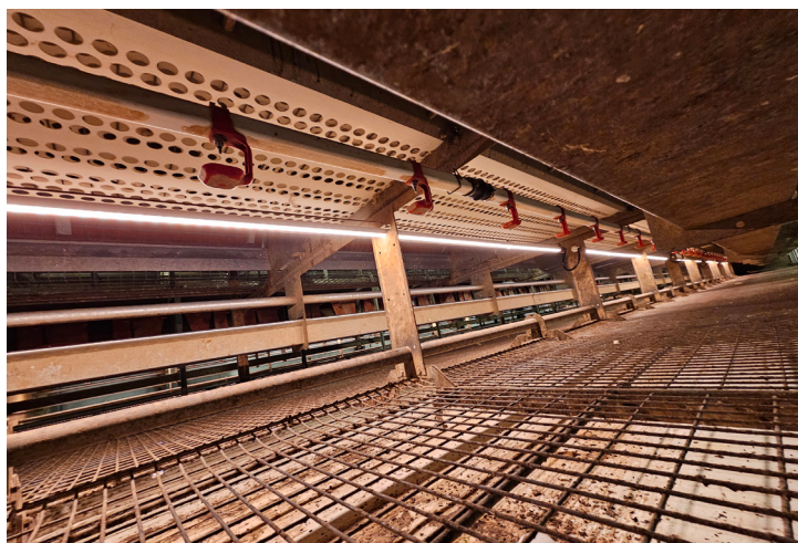
AVIARY-LIGHT zamontowana pod systemem wielopoziomowym.
