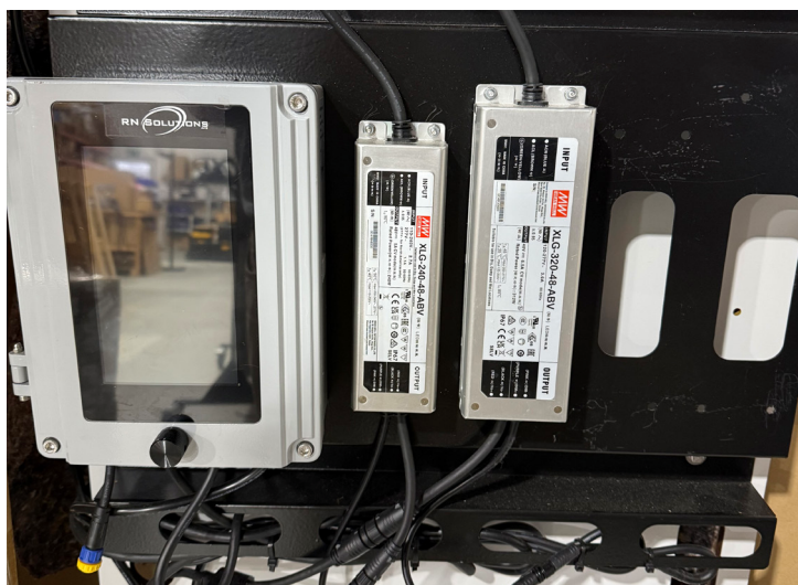
MeanWell-drivdon levereras kompletta som 100 % Plug 'N Play – kräver endast 1 × 13A CCE-kontakt per drivdonssats.
