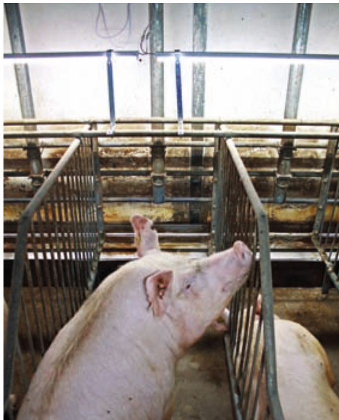
■ LED-armaturerne er nemme at montere og er placeret, så de ikke sidder i vejen.
